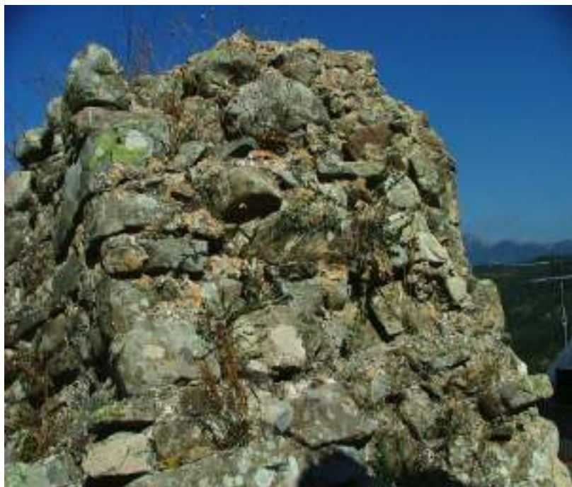
2. Torre 3, vista SE, particolare che evidenzia lo spessore della muratura
