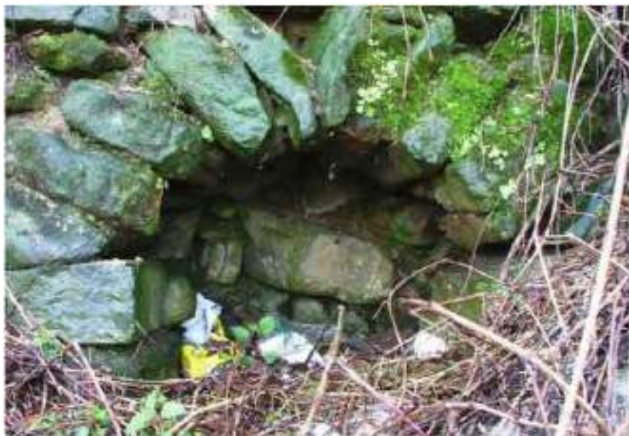
1. Saettiera, mura lato N, a ca 2 m dall'angolo della cinta muraria fra il castello e il circuito murario nord. Arco a tutto sesto con conci di arenaria posti a raggiera
