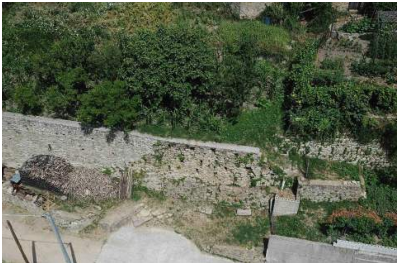
2. Cortina muraria tra torre 6 ed avancorpo murario n. 7, vista da SE
