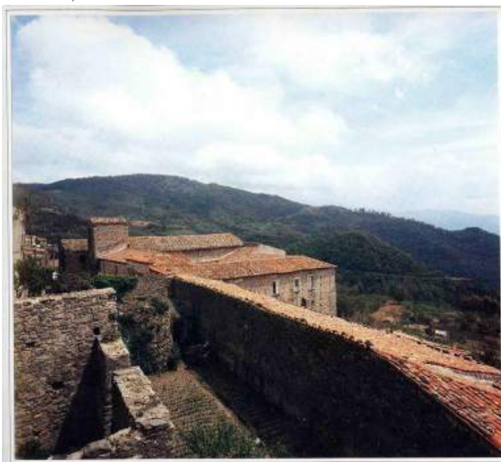
4. Torre II, stato di fatto.
