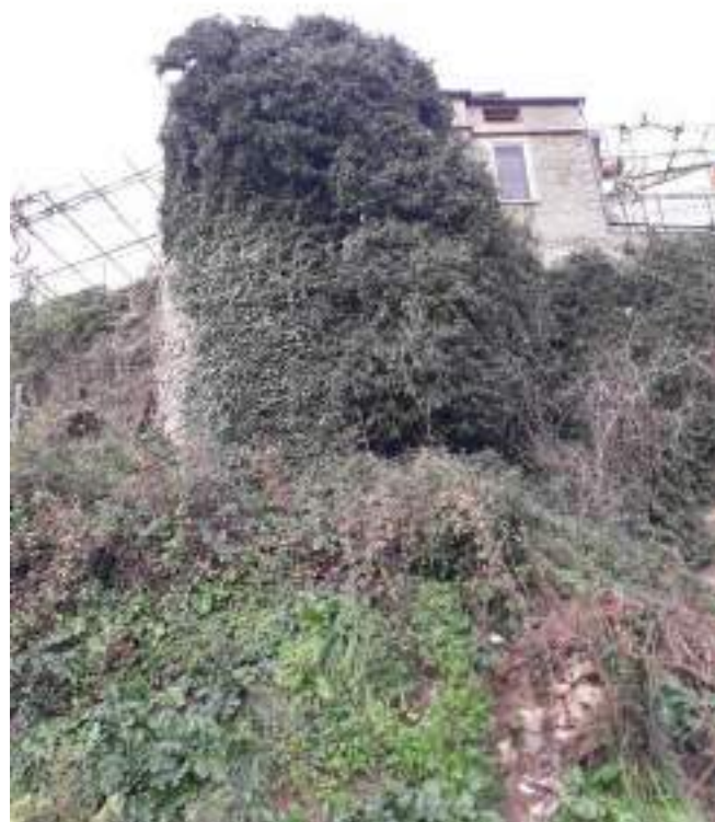
7. Torre 8. Stato di fatto. Vista da S
