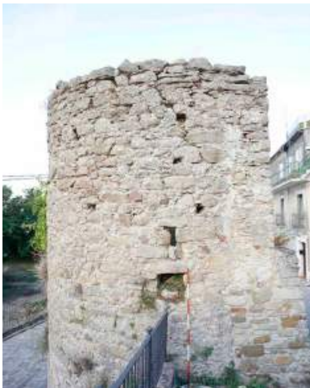
5. Torre 9, lato E. Particolare dell'arciera e foro a sezione quadrata. Stato di fatto
