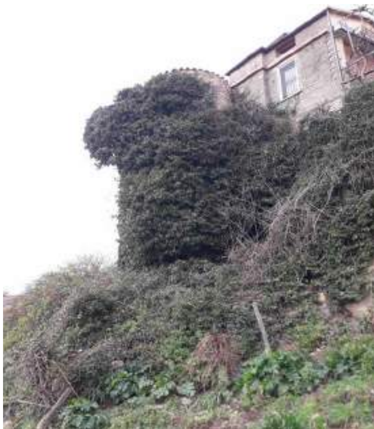
6. Torre 8. Stato di fatto. Vista da E
