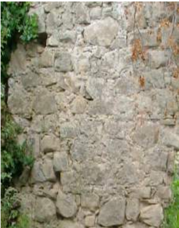
4. Torre 5, particolare della tecnica costruttiva con arenaria grigio-verde
