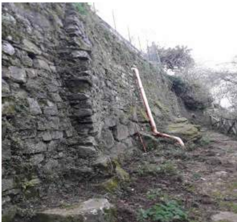
4. Cinta muraria, procedendo in direzione N, si nota la USM6 che poggia su USM 7
