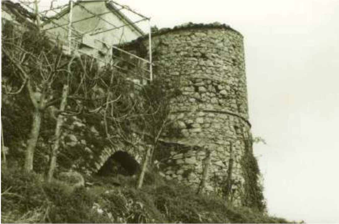
4. Torre 8, vista da SW. E' visibile parte della cortina muraria e un'apertura ai piedi della torre. (foto degli inizi degli anni '60)
