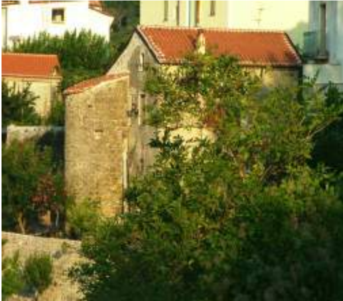
1. Torre 2, vista da W
