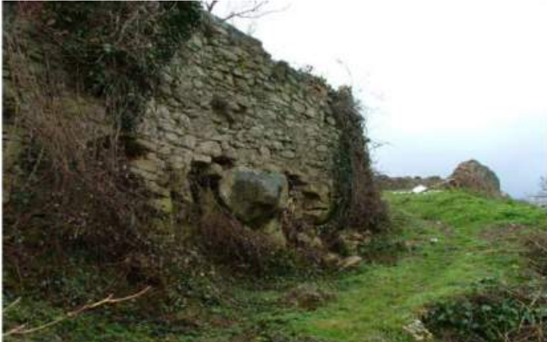
1. Muro di cinta, lato E, posto ad E della località Portello. Vista da NE (vd. planimetria CTR 1.5.000)
