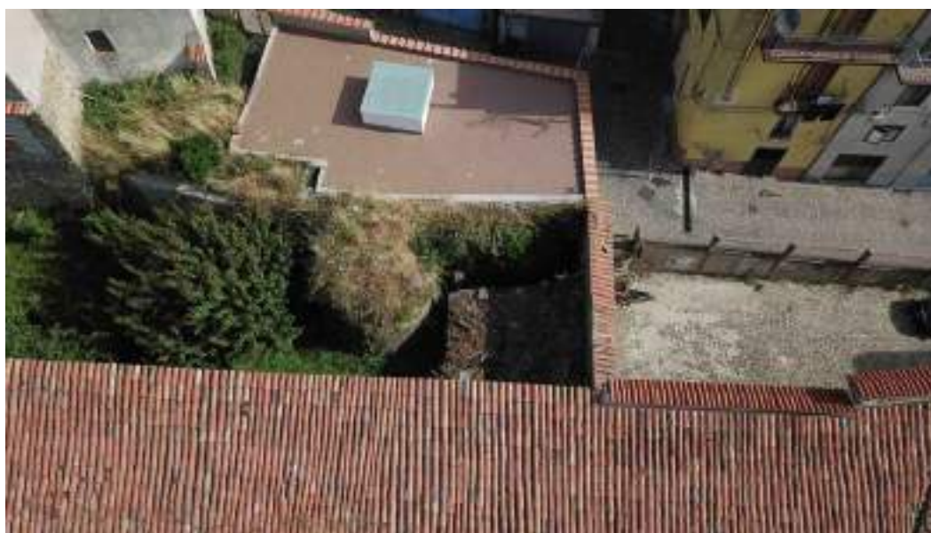
3. Torre II, stato di fatto (vista dall'alto).
