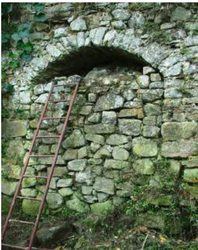
1. Postierla con tamponatura successiva, vista da W
