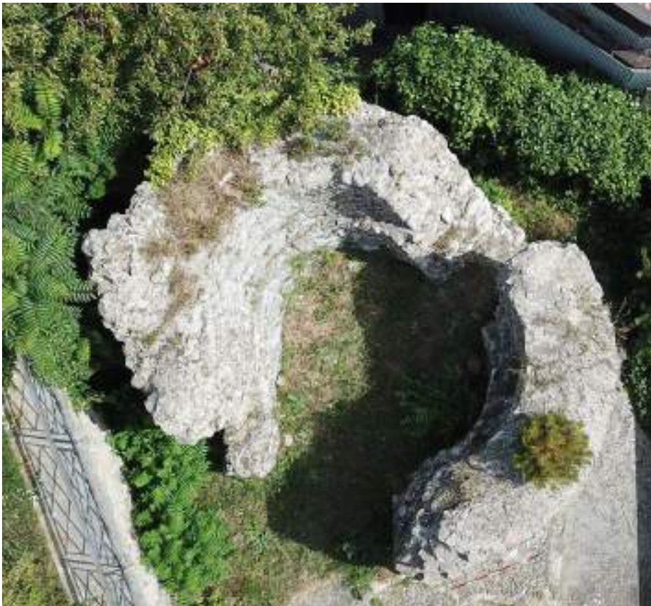
7. Torre 3, vista dall'alto
