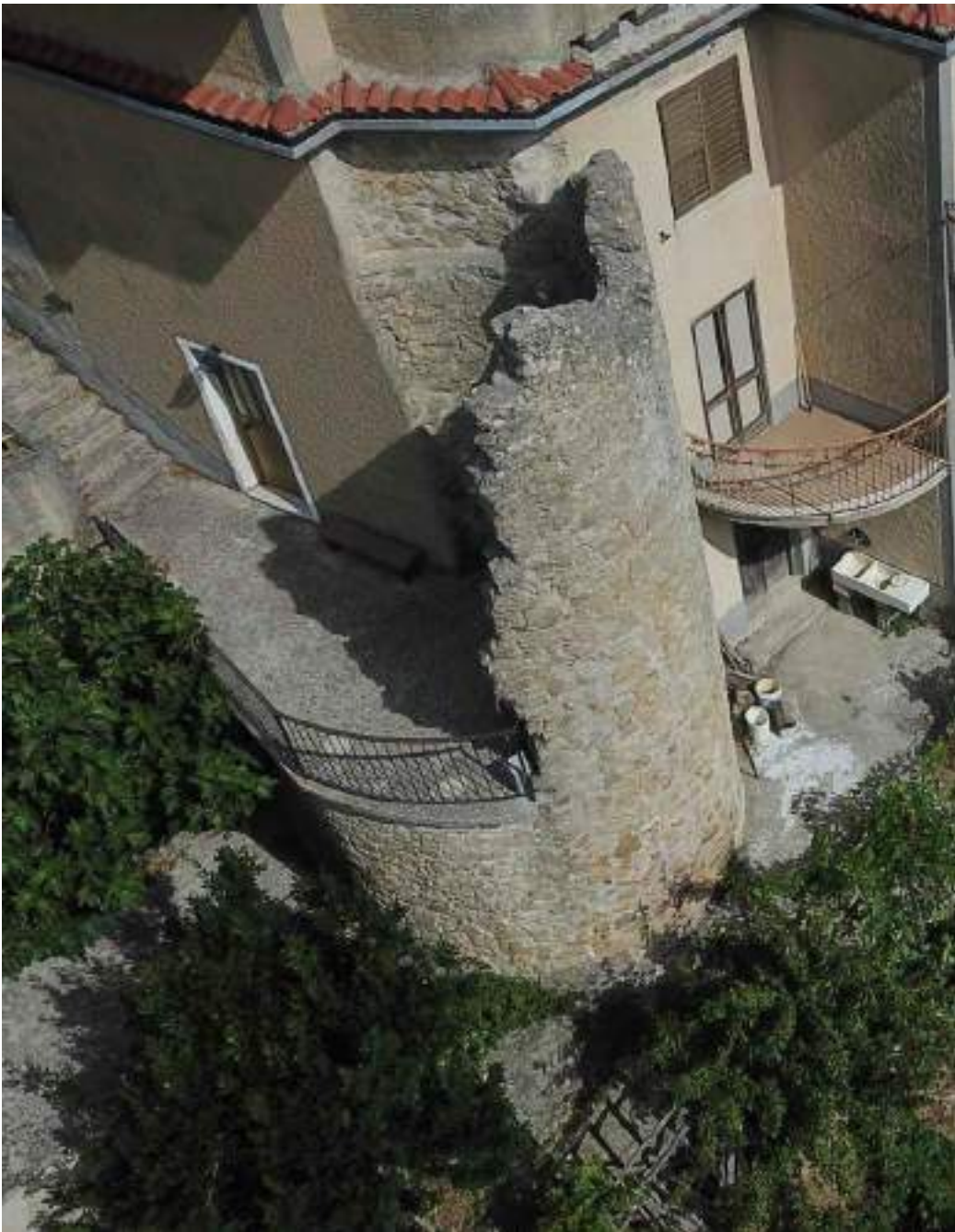
3. Torre 4, vista da SE, stato di fatto.
