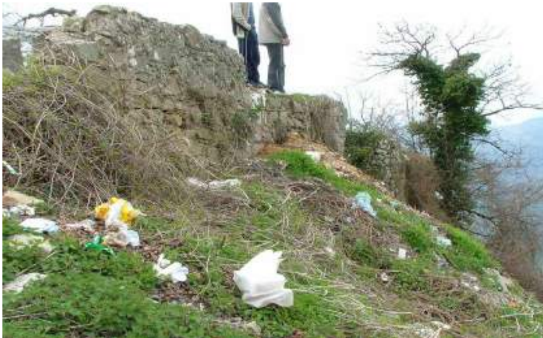
2. Muro di cinta, lato W, posto ad W della loc. Portello. Vista da NW (vd. planimetria CTR 1.5000)
