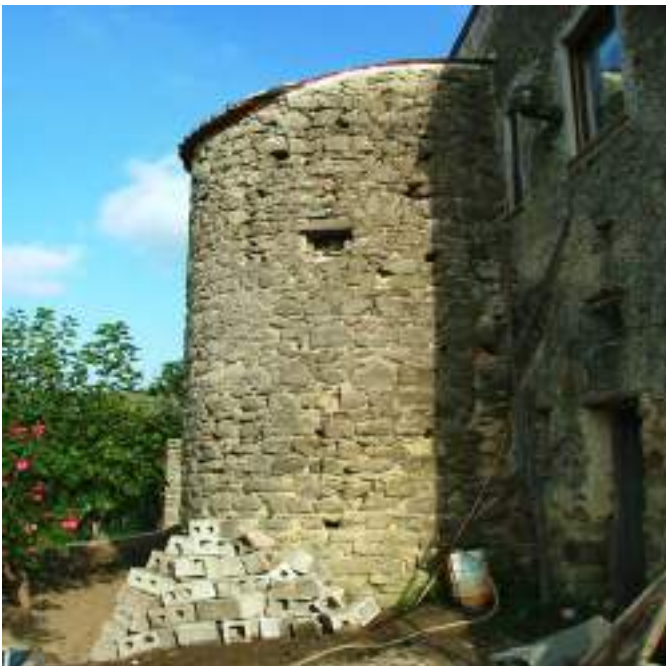
2. Torre 2, lato W. Particolare dell'arciera sul lato W successivamente tamponata.
