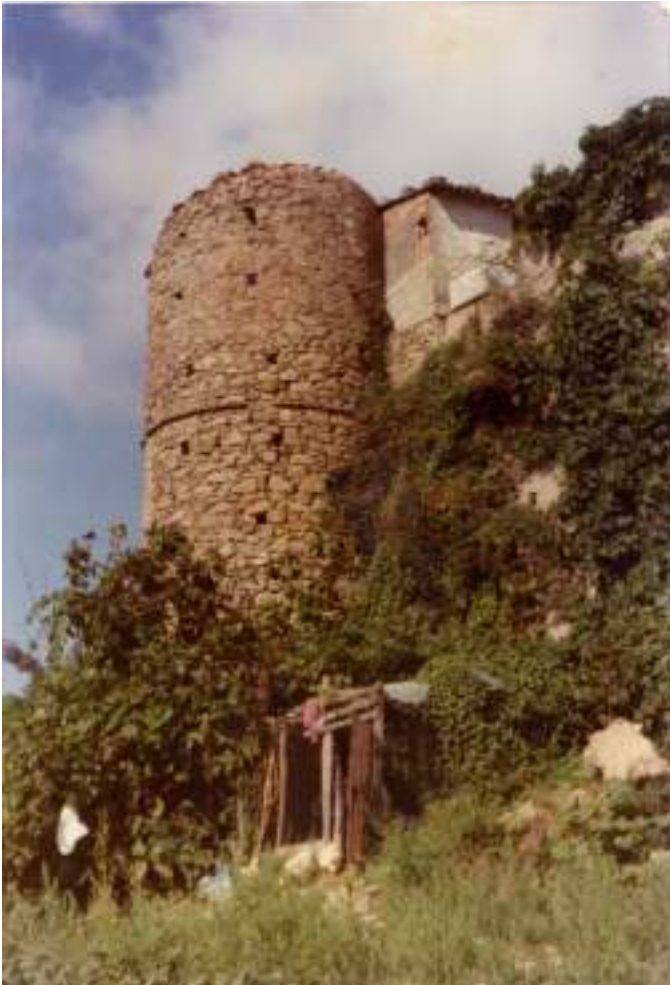
2. Torre 8, vista da SE. (Foto dei primi anni '70)
