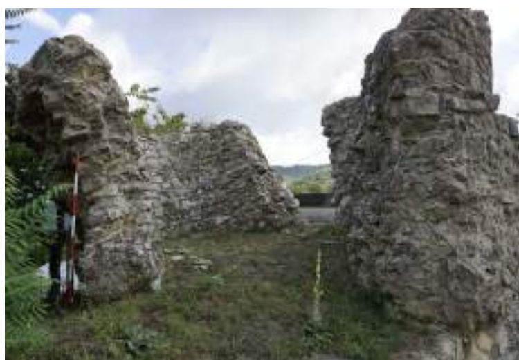
5. Torre 3, interno, vista da S_SW
