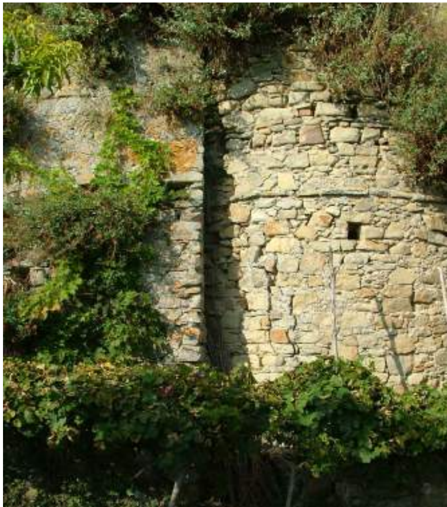
1. Torre 12, vista da W. Si nota come la torre si appoggia alla cortina muraria
