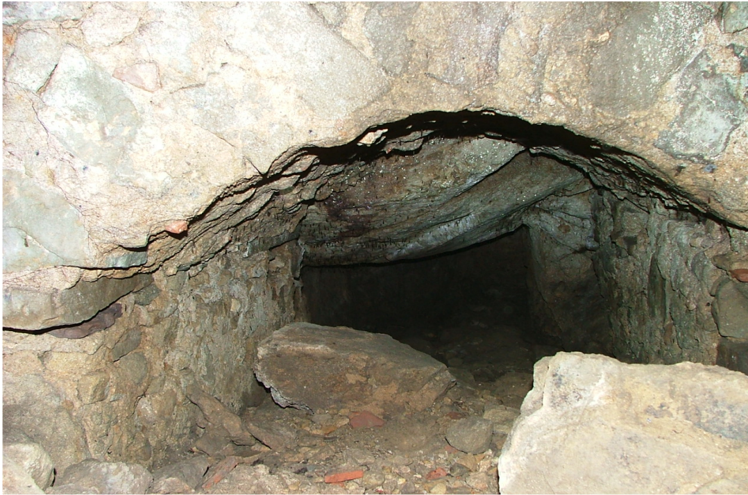
5. Cortina muraria ad W. Condotto in muratura USM 4 (vista interna)
