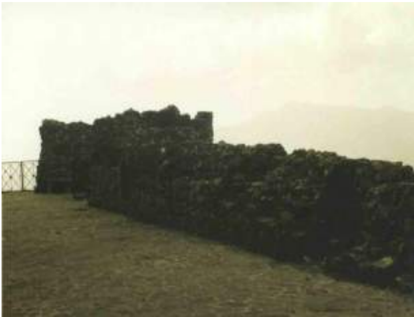
6. Recinto lato N. Vista da E
