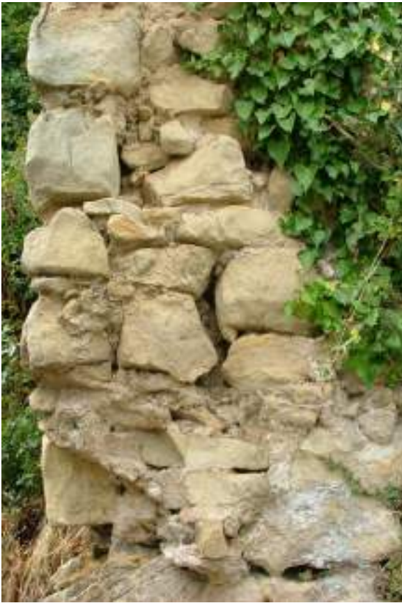
3. Torre 5, particolare della tecnica costruttiva con arenaria giallastra
