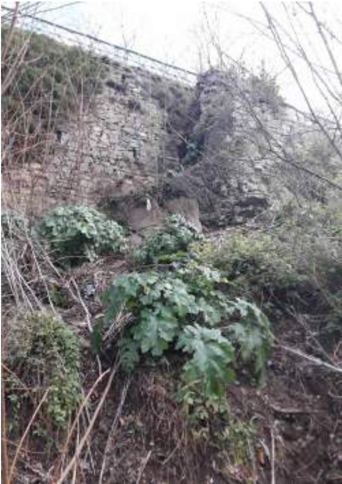
11. Recinto, lato W. Stato di fatto
