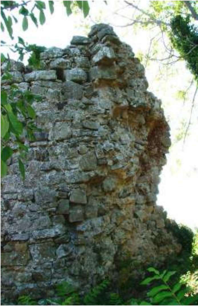
3. Torre 3, particolare lato W
