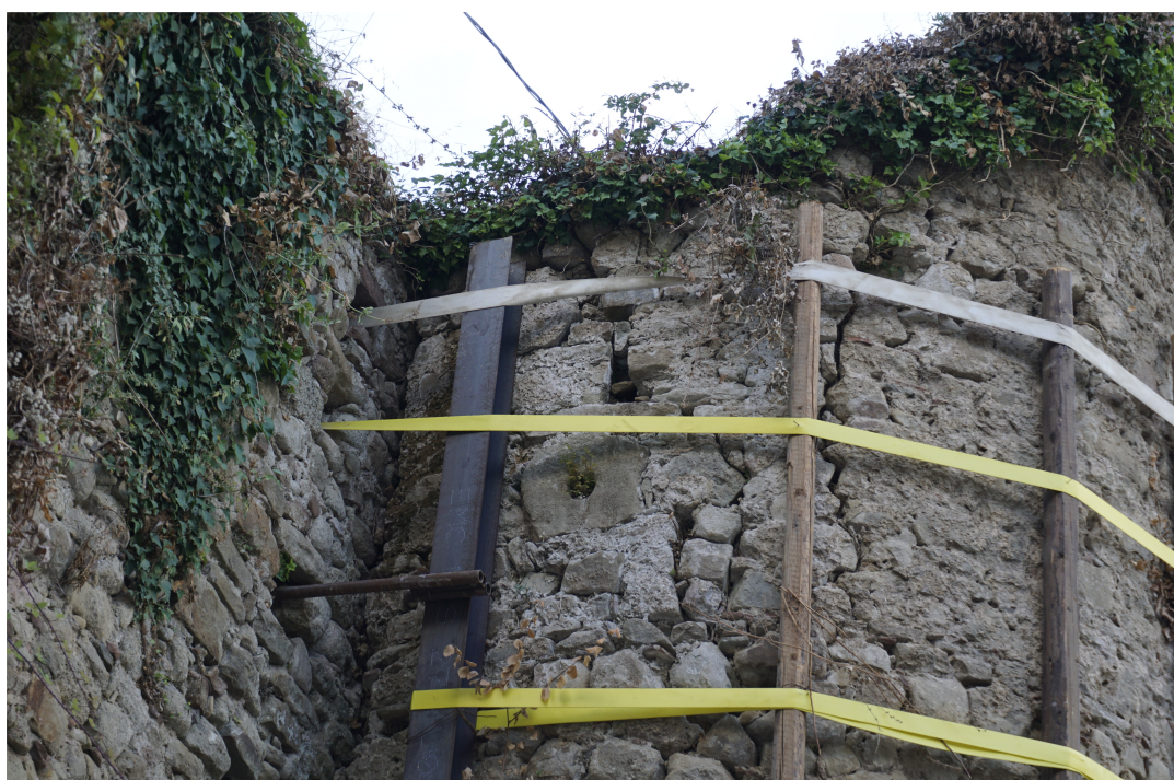
2. Torre 10. Particolare dell'arciera e dell'archibugiera lato W
