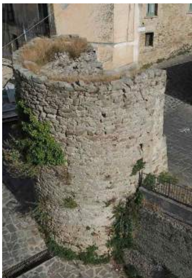
6. Torre 9, vista da SE. Stato di fatto
