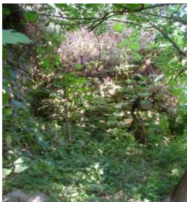
2. Torre 11, stato attuale della torre
