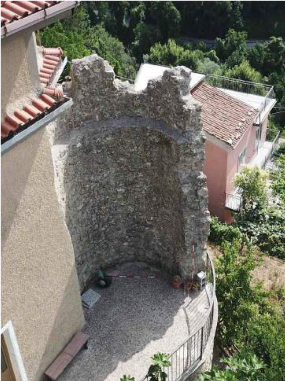
2. Torre 4, vista da SW, stato di fatto
