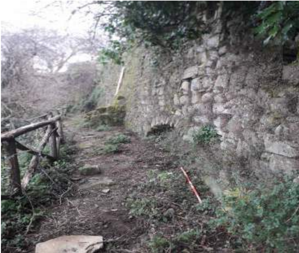
1. Cinta muraria, generale. Vista da W
