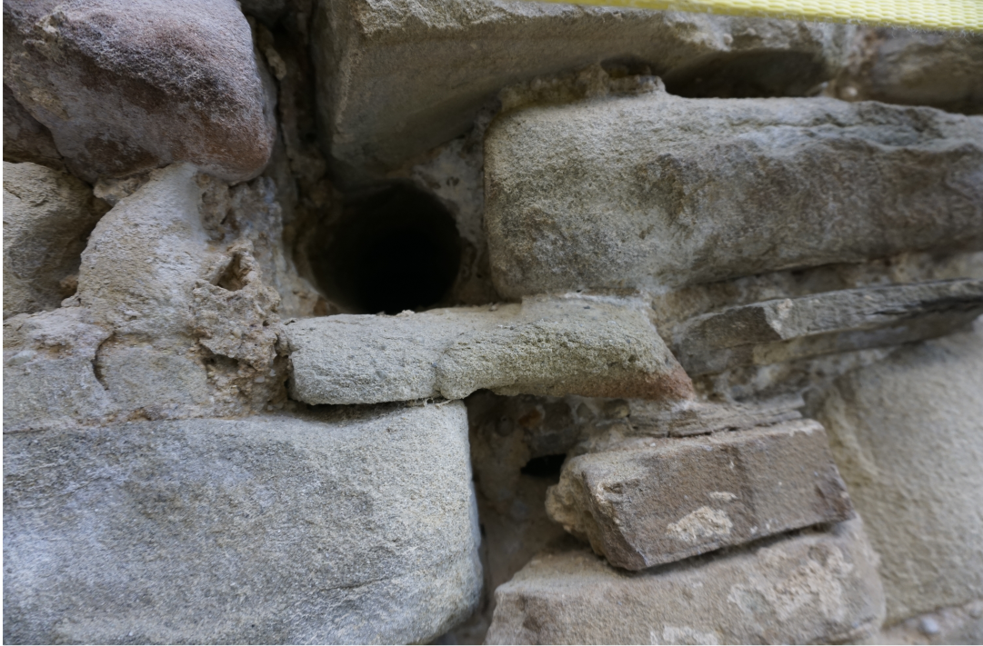
3. Torre 10. Particolare dei fori per impalcati
