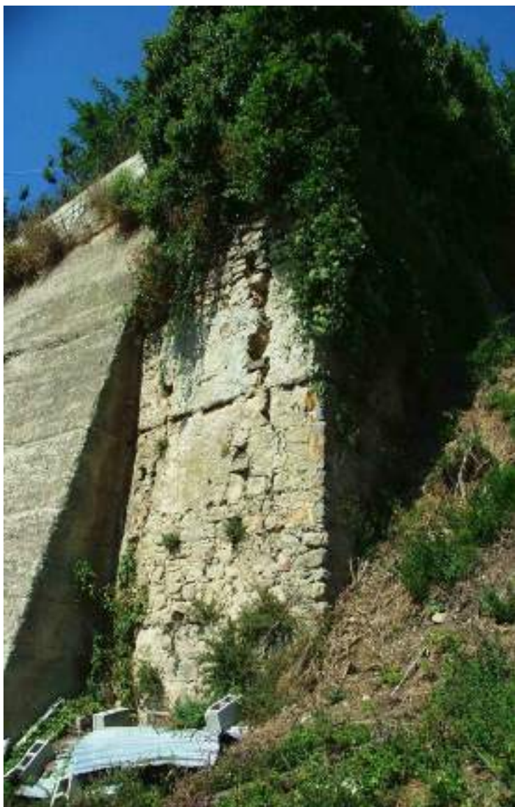
1. Avancorpo murario con base scarpata e redondone. Foto dei primi anni '70. Vista da SE
