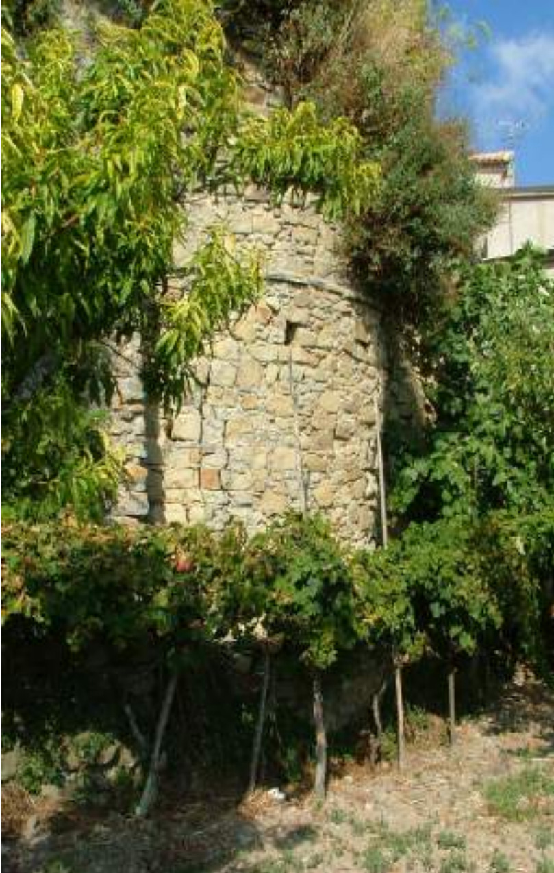
2. Torre 12, vista da SW
