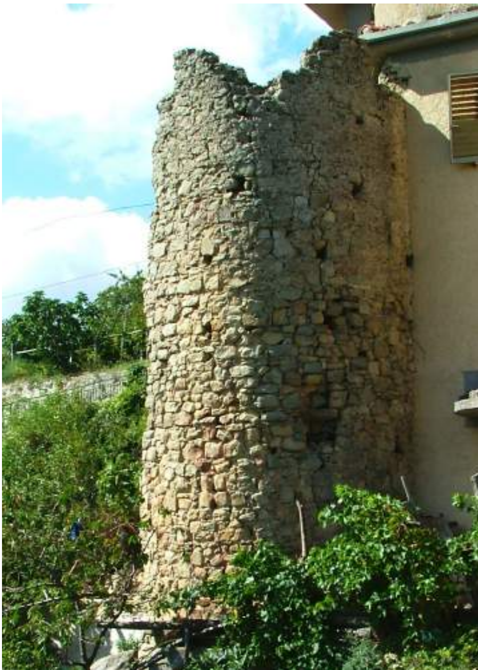
1. Torre 4, vista da E
