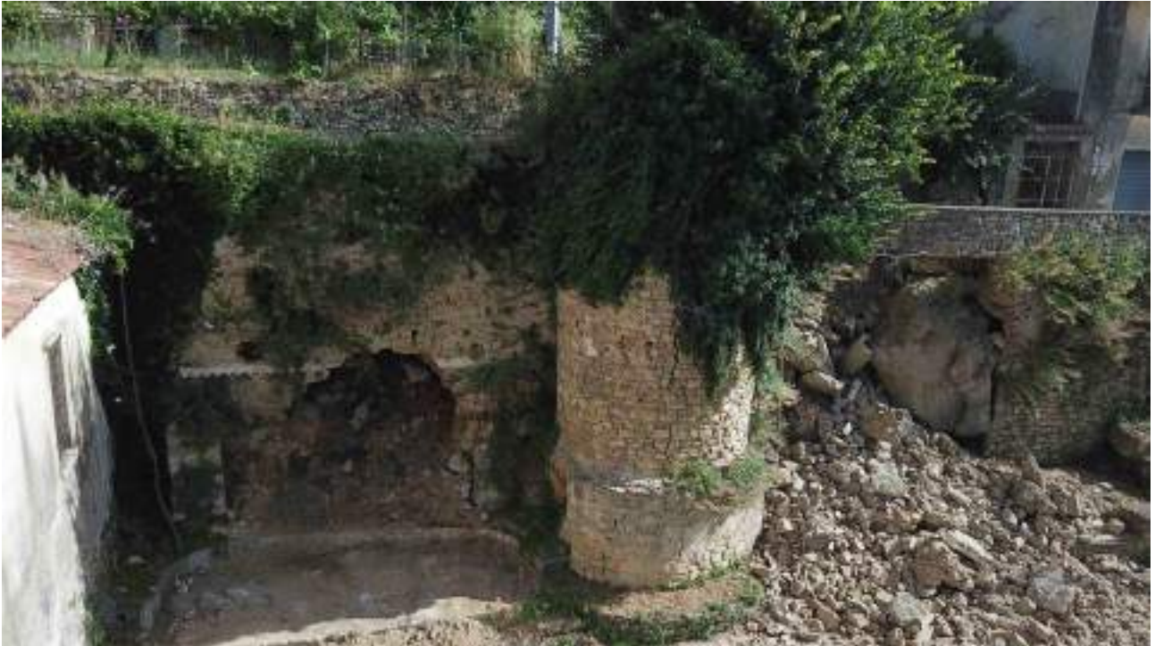
1. Torre 10 e cortina muraria, vista da S. In particolare lo stato di fatto successivo al crollo avvenuto a Giugno 2021 che non ha intaccato le strutture antiche. La muratura ad W è frutto di vari rifacimenti a partire dagli anni '50 del '900.
