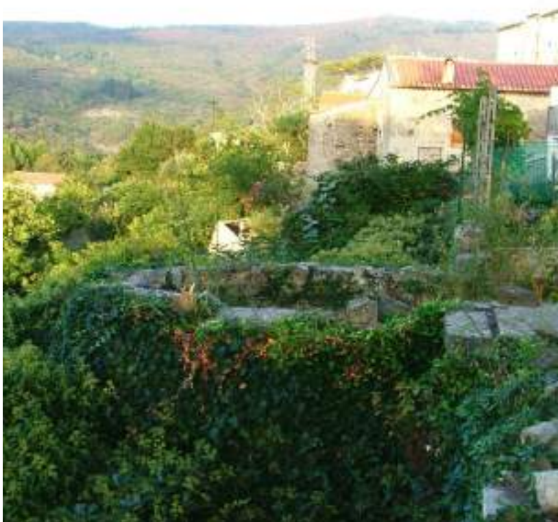
7. Torre 1, in primo piano la scapitozzatura della torre 1 in secondo piano la torre 2.
