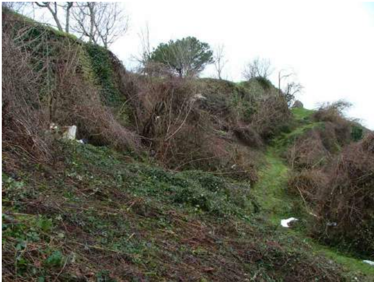
3. Loc. Portello, stato di fatto. Vista da NE
