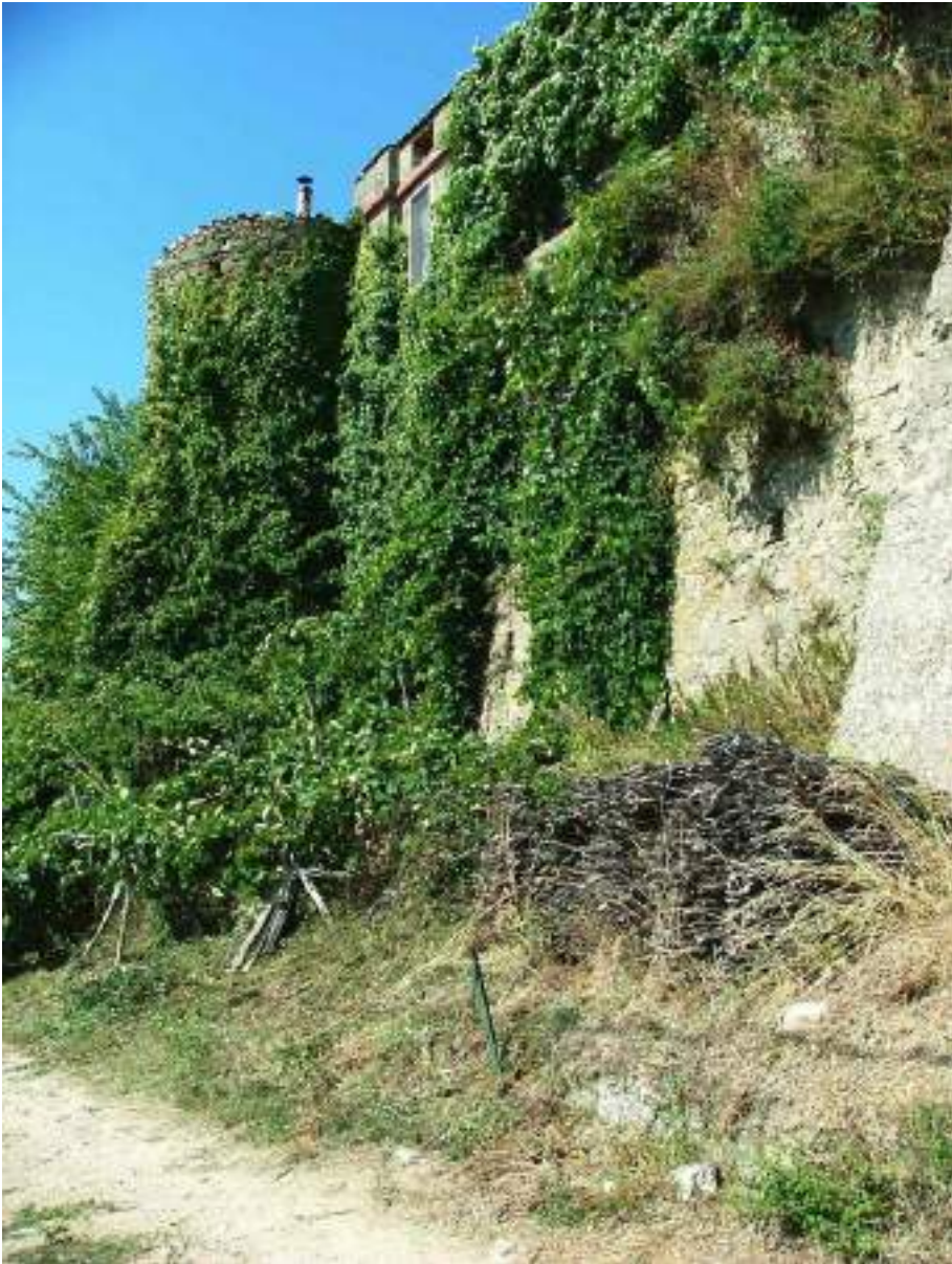
1. Torre 8, vista da E
