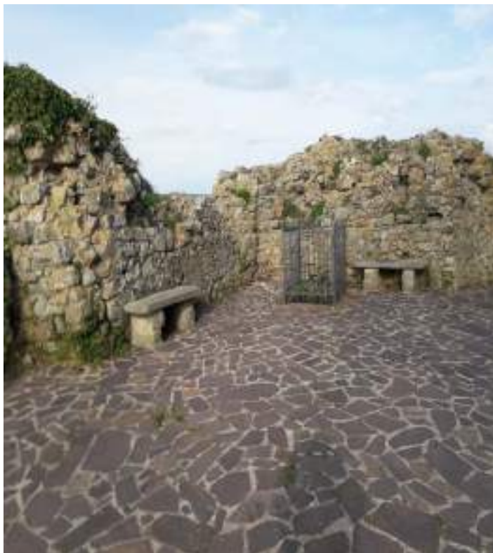
7. Mastio, cantonata, interno. Vista da E
