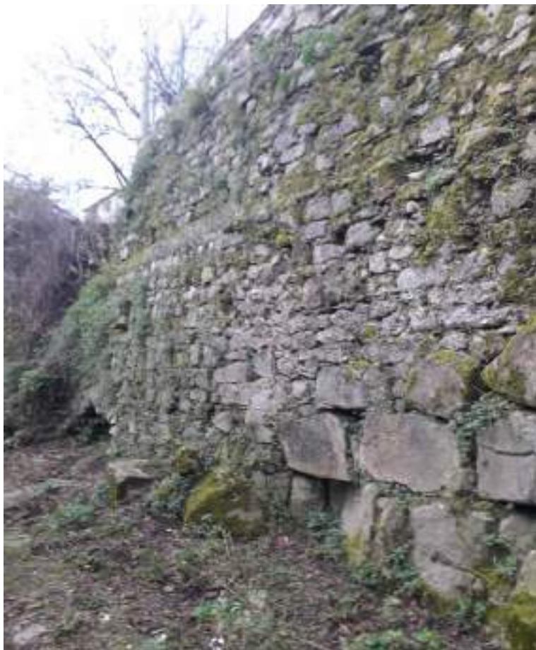
3. Cinta muraria, particolare della USM 7 con tecnica muraria costituita da grandi blocchi di arenaria messi in opera a secco
