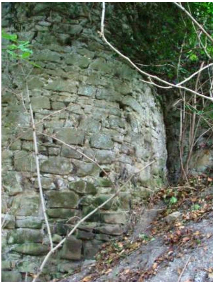
1. Torre 1, fianco N.
