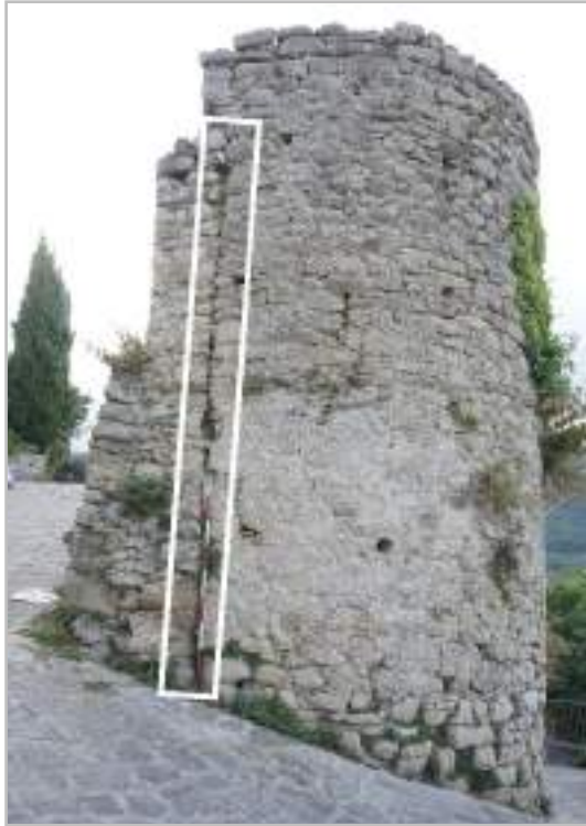
Torre 9: linea di giunzione tra resti della cinta muraria e la torre
