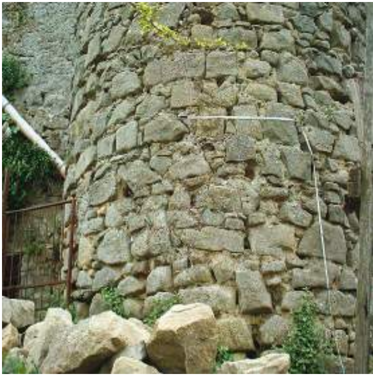
3. Basamento torre lato N. In evidenza i fori circolari per gli impalcati lignei. In alto a destra, particolare foro
