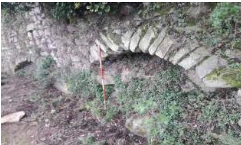
2. Cinta muraria, particolare del II arco di scarico in direzione N. Vista da W
