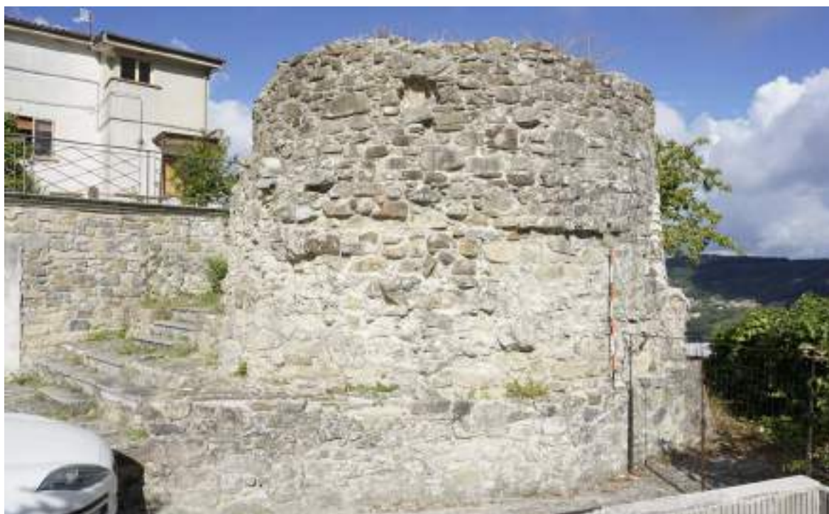
4. Torre 3, vista da SE
