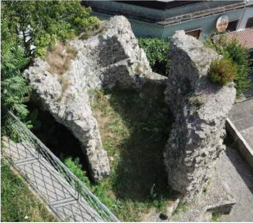
6. Torre 3, particolare delle murature
