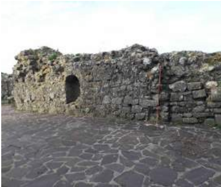
9. Mastio, recinto, interno, particolare con finestra tamponata.
