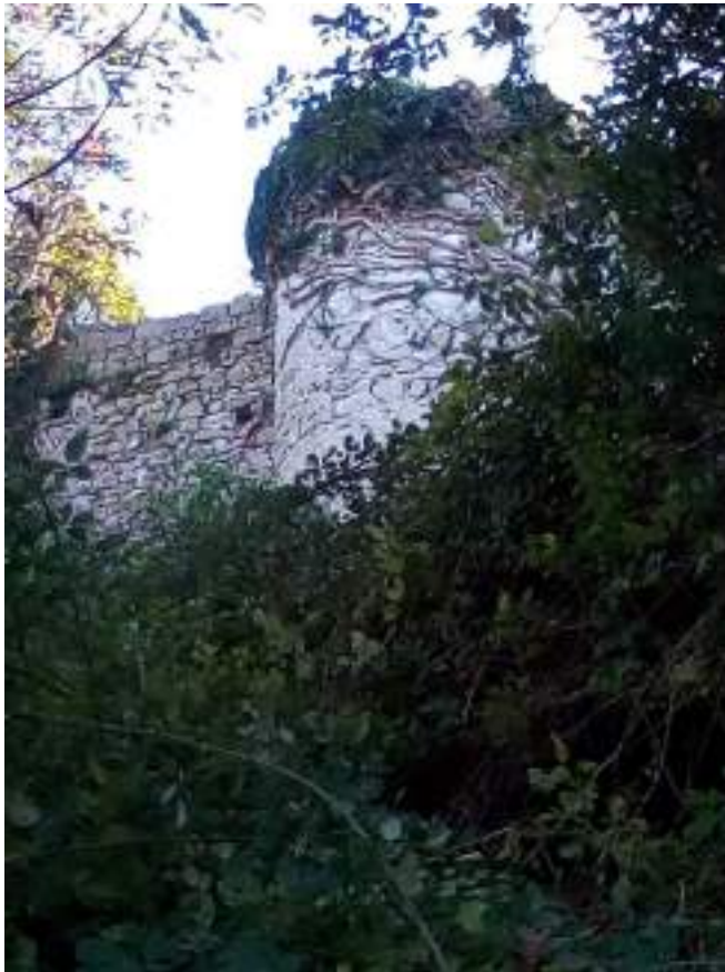
5. Torre 1, fianco E con resti di cinta muraria in direzione S
