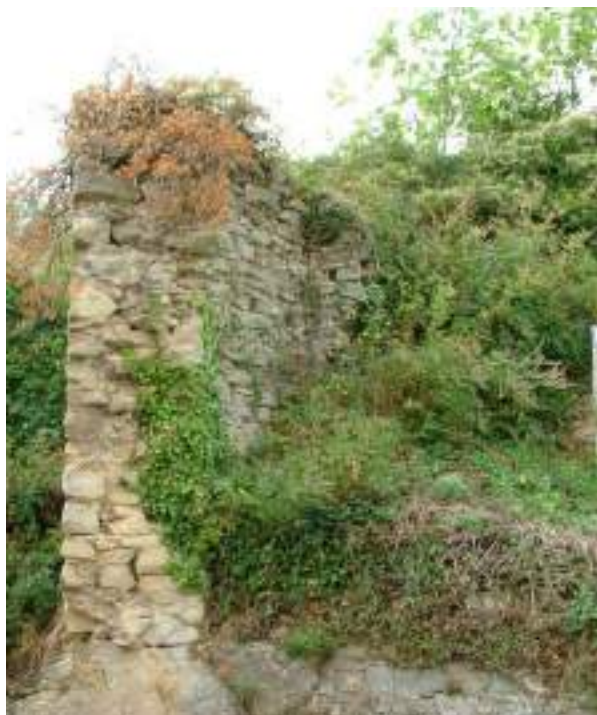
1. Torre 5, particolare del banco arenaceo su cui poggia la torre. Vista da E
