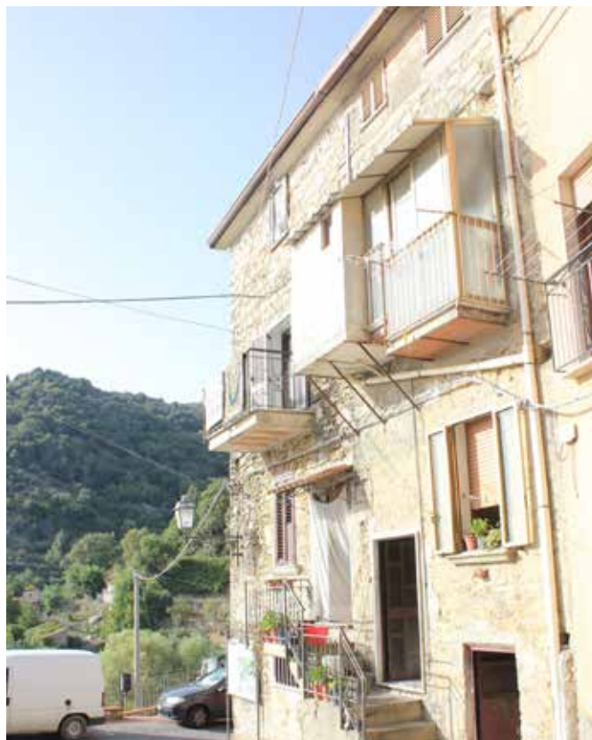
Cardile. Edificio via Vaglio. ESEMPIO NEGATIVO.
