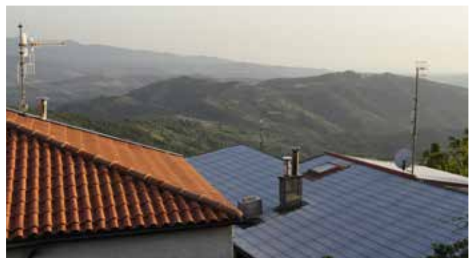
Gioi. Dettaglio coperture.
