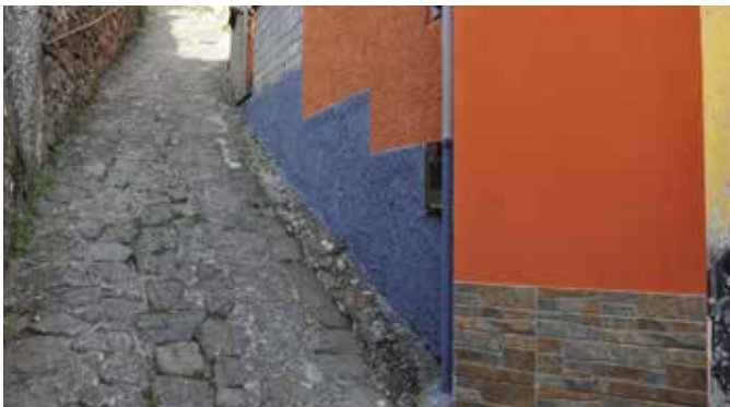
Cardile. Edificio in via S. Rocco. ESEMPIO NEGATIVO.
