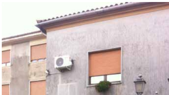
Gioi. Edificio in p.zza A. Maio. ESEMPIO NEGATIVO.
