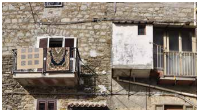
Cardile. Edificio in via Vaglio.
