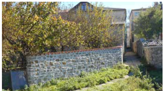
Gioi. Dettaglio vicolo dei lavatoi ("portello").
