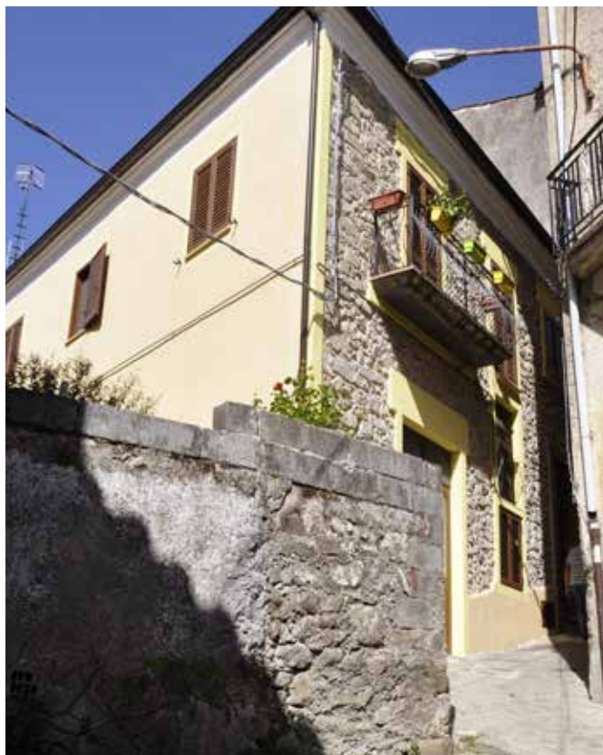
Gioi. Edificio in via Risorgimento. Finitura facciate: ESEMPIO POSITIVO. Colore e forma della zoccolatura: ESEMPIO NEGATIVO.
